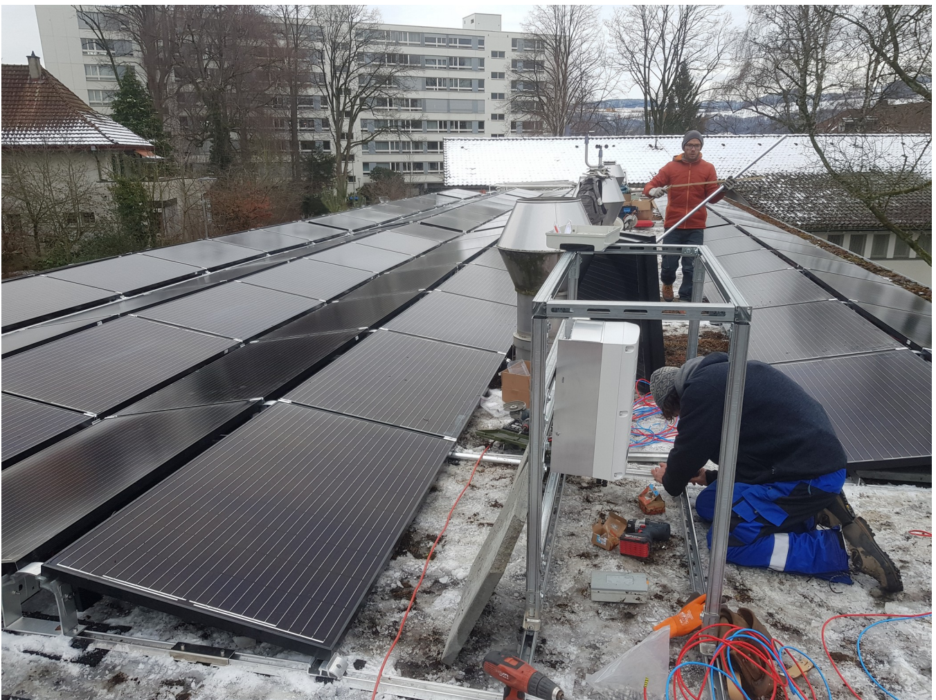
Abbildung 9: Arbeiten an der Anlage Sonnenhof in Bern.
