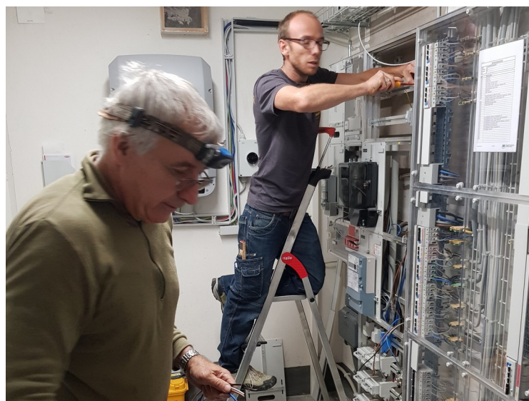
Abbildung 2: Hans Moser (externer Mitarbeiter) und Romain Kälin (Projektleiter) bei Arbeiten an der Hauptverteilung einer PV-Anlage.
